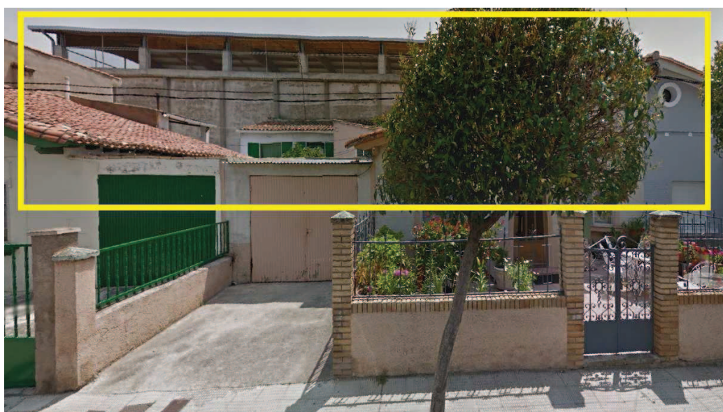
Imagen 2. Vista desde c/ Fermín Arteta donde se observan edificaciones adosadas al muro del frontón
