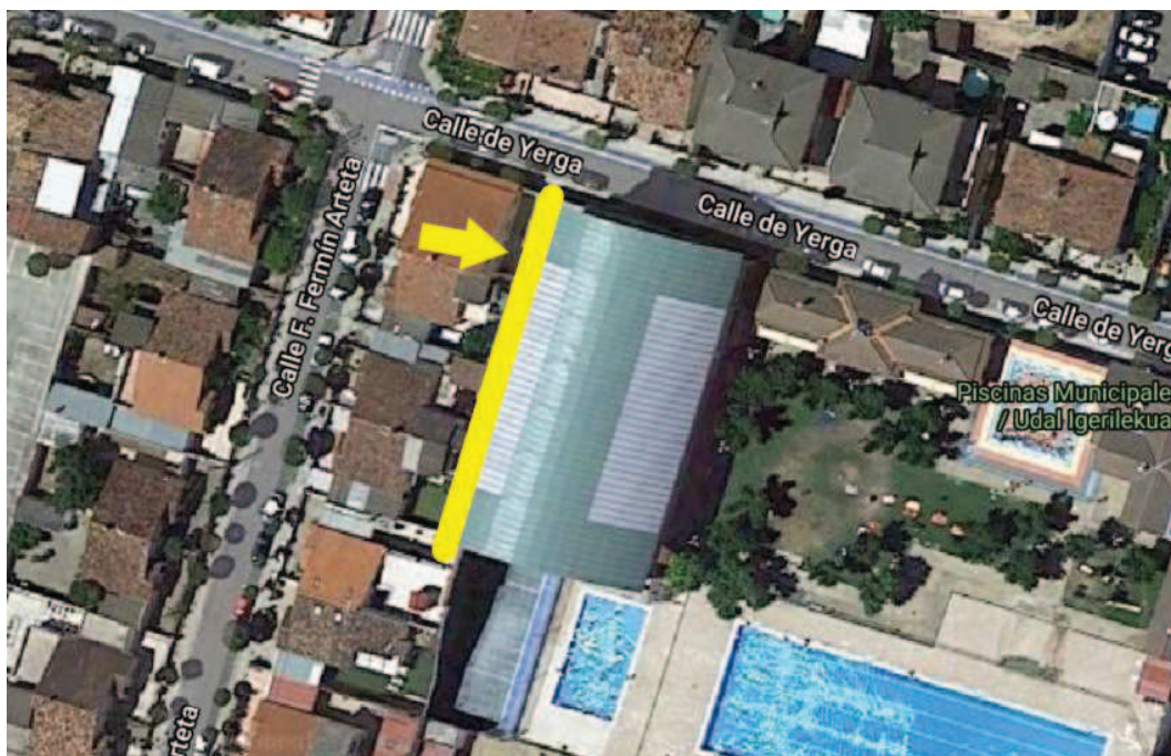
Imagen 1: Vista aérea de la ubicación de la pared del frontón con patologías
